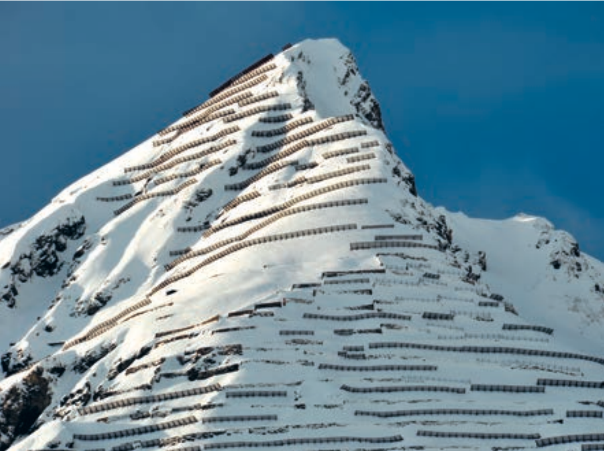
Abb. 4: Landschaftsprägend: Im Lawinenanrissgebiet am Schiahorn oberhalb Davos (GR) stehen insgesamt rund 10 km Stützwerke und Mauern. Die ersten Mauern wurden 1920 aus Steinen erstellt, die neusten Stützwerke aus Stahl können eine bis zu 5 Meter hohe Schneedecke stabilisieren und diese am Anbrechen hindern. © S. Margreth, SLF
