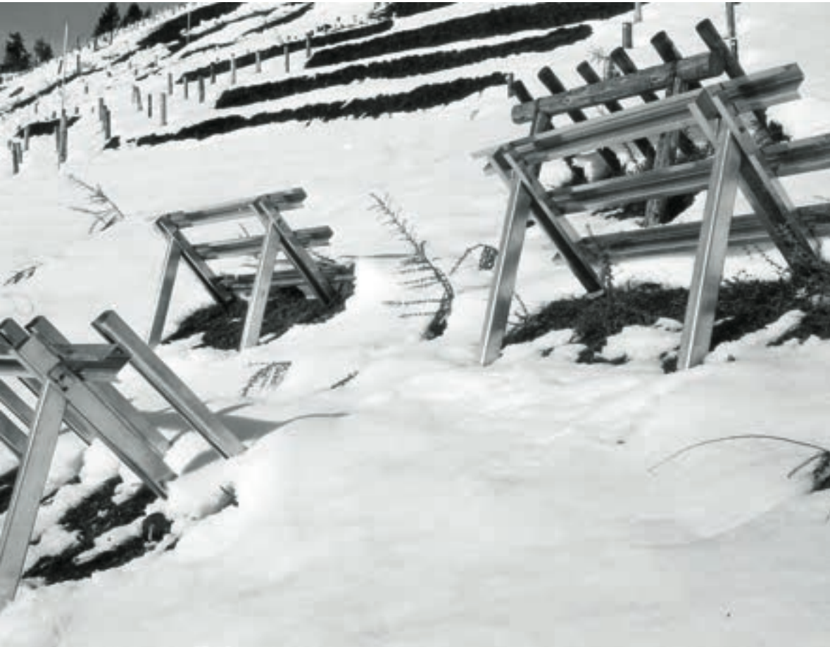
Abb. 5: Versuchsbau, der 1951 vom SLF auf dem Dorfberg (GR) erstellt wurde. Stützverbauungen sind der wichtigste bauliche Lawinenschutz in der Schweiz: Mehr als 500 km Stützwerke verhindern das Anbrechen von Lawinen und prägen so die alpine Landschaft massgeblich. © Archiv SLF
